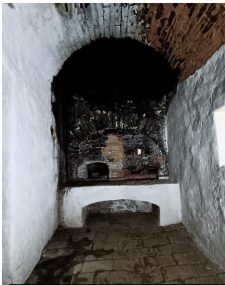
Foto: Interiér kulturní památky čp. 25, černá kuchyně z roku 1844 po obnově.
